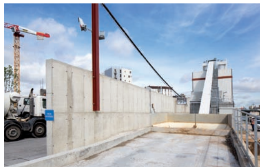
Un mur antibruit situé au niveau de la zone de déchargement des granulats contribue à améliorer le confort sonore.
