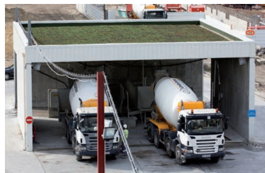
Pour une intégration paysagère harmonieuse, des toitures végétalisées recouvrent les toits des installations.
